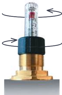
3 С помощью ключа, вращая колбу расходомера, выставить требуемое значение расхода теплоносителя (л/мин)
